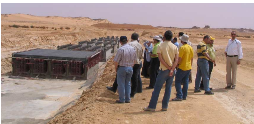
Visite de terrain au Projet de Développement de la Vallée Sud: siphon sous le canal de déversement (Egypte)
